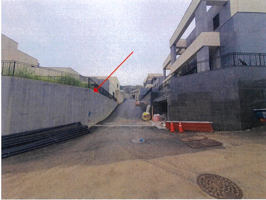
【 본건 전경 및 주위환경 】
